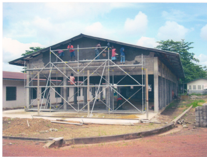
Salone multiuso in costruzione nel Saint Joseph Institute
