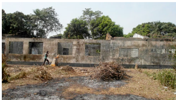
Masiaka: attuali condizioni dell'edificio da recuperare per il Centro di Accoglienza
